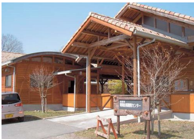
環境技術開発センター全景（飯田市）
